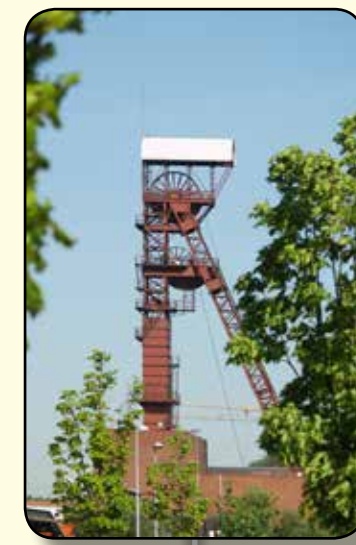
Hückelhoven: Schacht 3 der ehem. Zeche Sophia-Jacoba (ca. 6,4 km)
