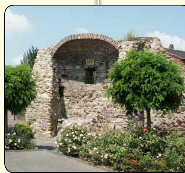
Wassenberg: Verlorenturm ca. 277 m
