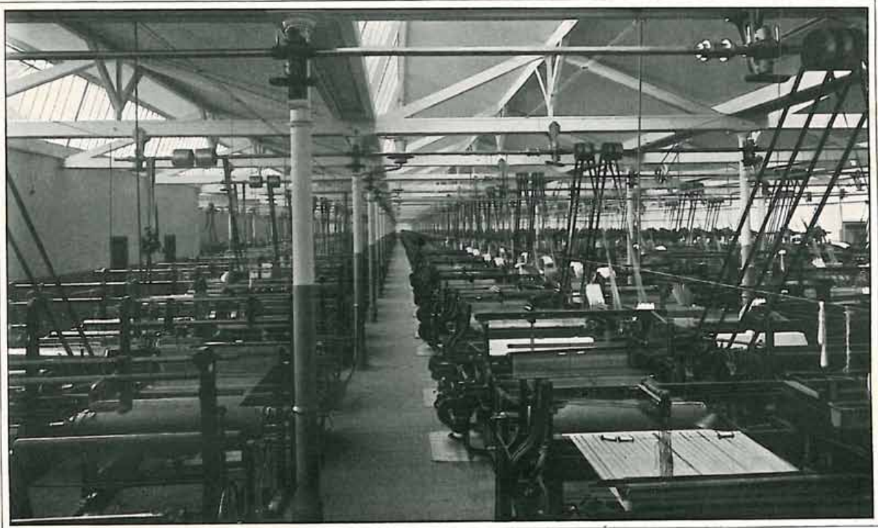
Großer Websaal. (Wassenberg, Fabrik I.)
