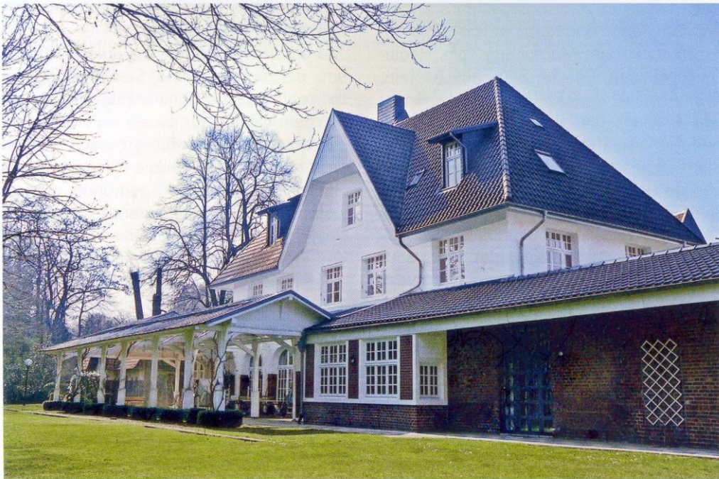
Abb. 2: Der Bahnhof Wassenberg ging 1990 in Privatbesitz über und wurde aufwändig saniert. Gut zu erkennen ist immer noch der Bahnsteig, der als Wintergarten erhalten blieb, das Stellwerk mit Anbau und der Paket-An- und Ausgabestelle. Foto: Dr. Ulf R. Püschel, 2012
