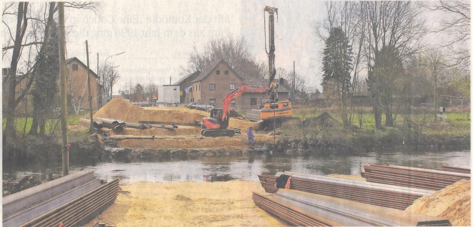
Die Spundwände für den Neubau der Rurbrücke wurden gerade geliefert, die Erdarbeiten haben begonnen.
